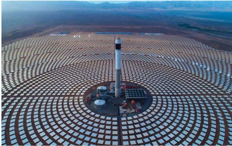
Figure 1- 4: Centrale solaire à tour
